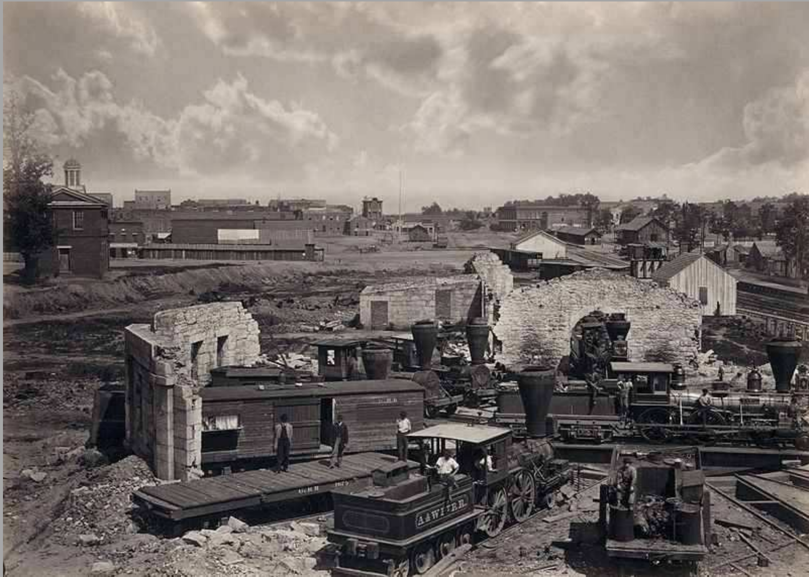
Zerstörtes Eisenbahndepot in Atlanta
